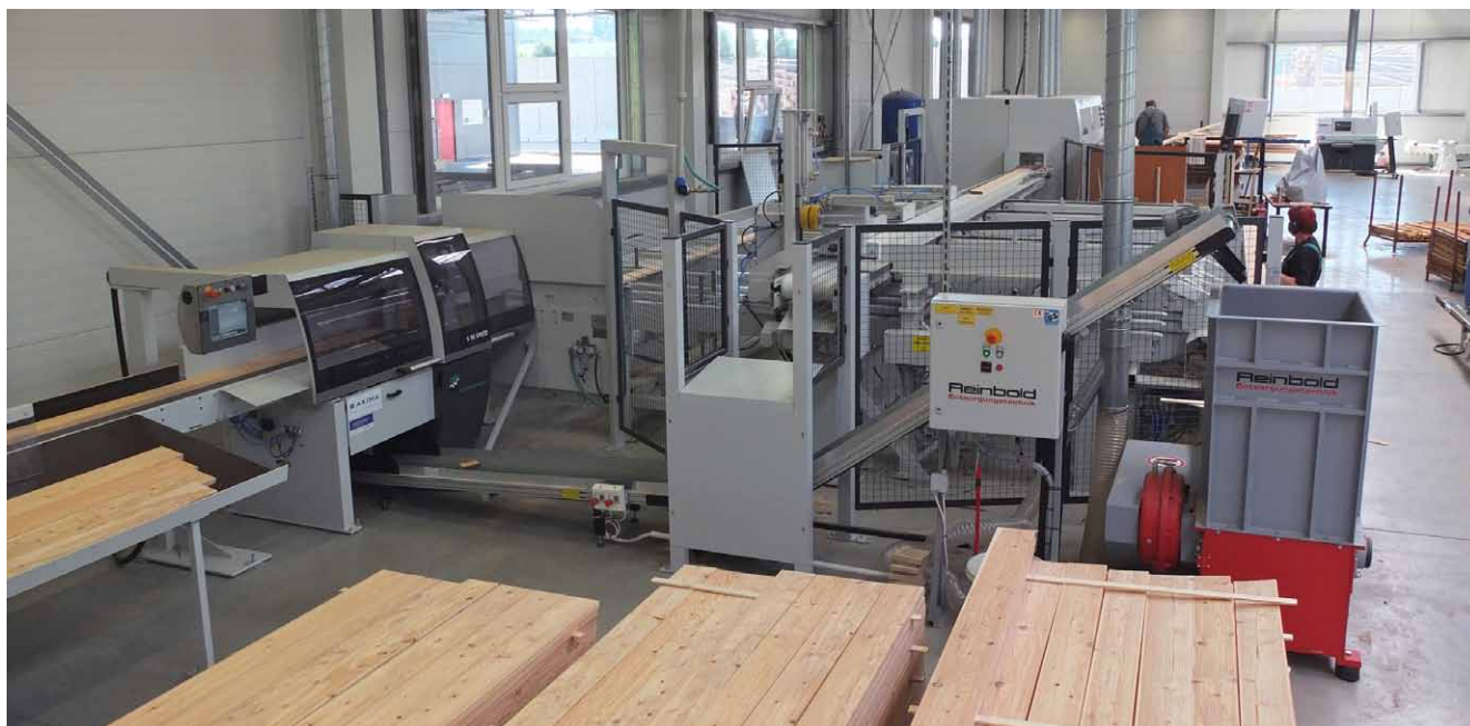
Profilovací a optimalizační linka WEINIG: vlevo zkracovací pila OptiCut S 90 Speed, vpravo drtič dřevního odpadu REINBOLD, směrem dozadu příčný dopravník a čtyřstranná frézka Powermat 1200, zcela vzadu vpravo rozmitací pila VarioRip 310
