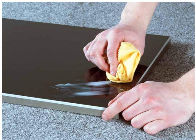
U jemnějšího vlasového poškrábání se ruční oprava provede vyleštěním pomocí brusné pasty
