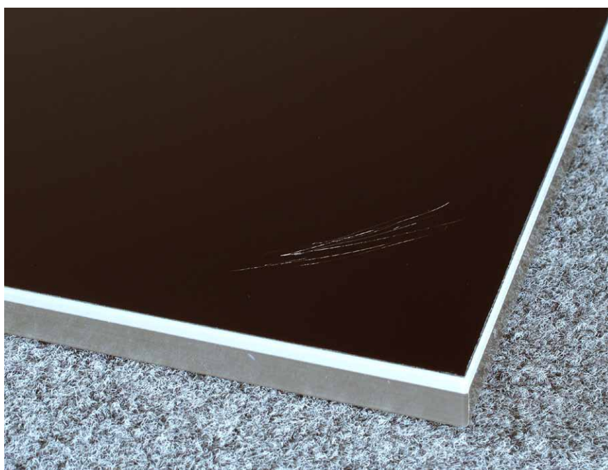
Drobné povrchové defekty, jako je jemné poškrábání apod., lze z vysoce lesklé akrylátové plochy relativně snadno odstranit i v „domácích“ podmínkách
