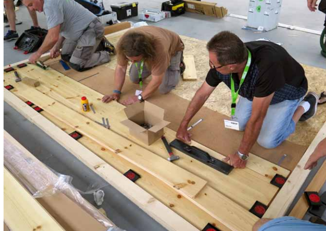
Odpoledne probíhaly praktické montáže pokládky šroubováním, pomocí speciálních spojovacích sponek (plovoucí způsob)...
