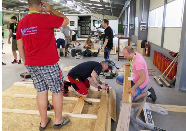
Odpoledne probíhaly praktické montáže pokládky šroubováním, pomocí speciálních spojovacích sponek (plovoucí způsob)...
