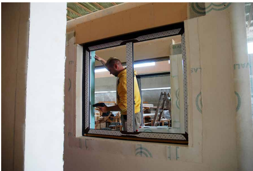
Výrobná hala poskytuje konštantné podmienky na montáž komponentov za každého počasia
