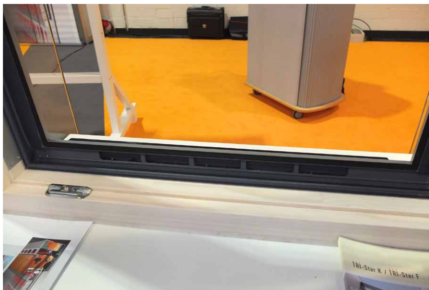
Nasávací průduch na vnější straně rámu
