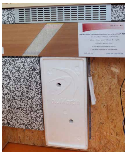
Ve stěně pod oknem je zabudovaná ventilační jednotka s průduchem situovaným těsně pod parapetem. Mezi ventilační jednotkou a průduchem je umístěno ploché IR topné těleso
