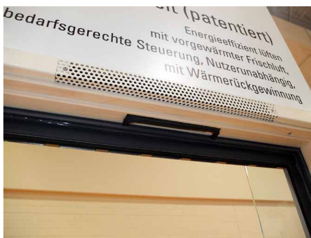
Průduchy v křídle a v rámu pro přívod vzduchu z meziskelního prostoru k hornímu dvoucestnému ventilu
