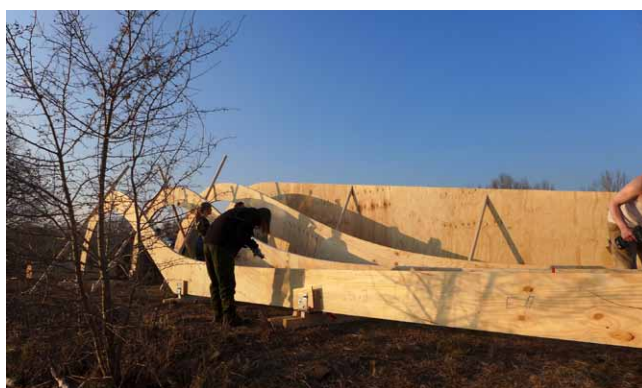
Vztýčenie nosníkov na mieste pozorovania
