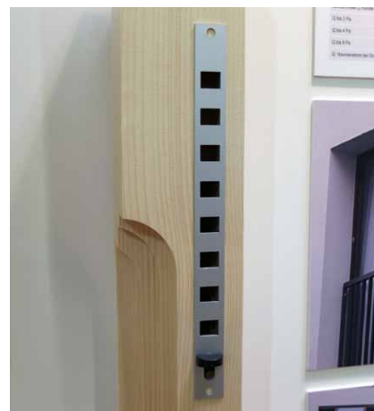
Z interiérové strany je otvor opatřen uzavíratelnou hliníkovou mřížkou
