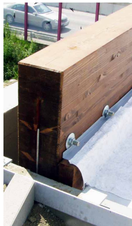
Ukotvenie nosného lepeného nosníka na betónovom základe
