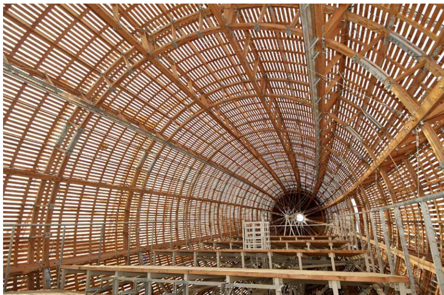
Provedení příhradových obručí a podélných ztužujících prvků dřevěné nosné kostry a její upevnění k ocelové mostovce
