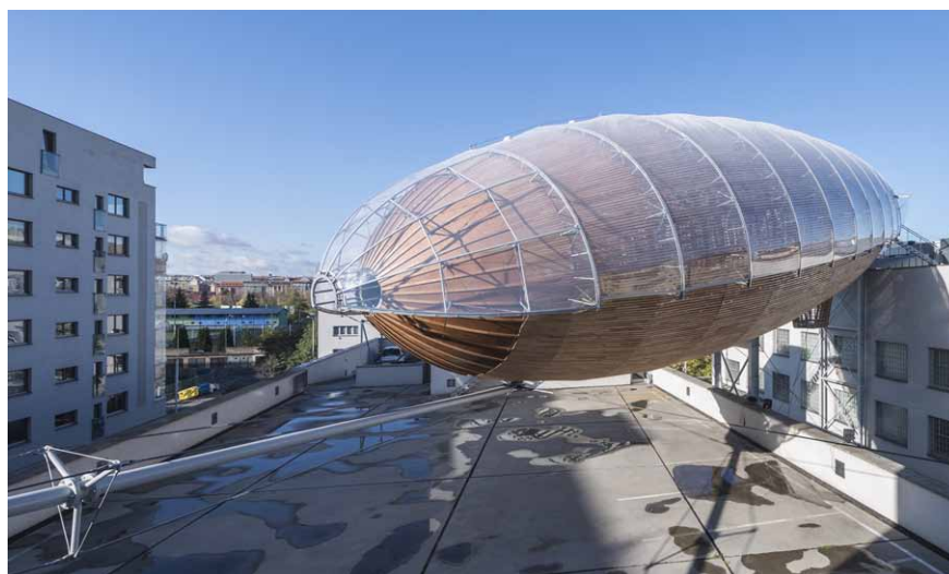
Podpůrná konstrukce se svislými bárkami, vykonzolovanou mostovkou a zajišťujícím ráhmem
