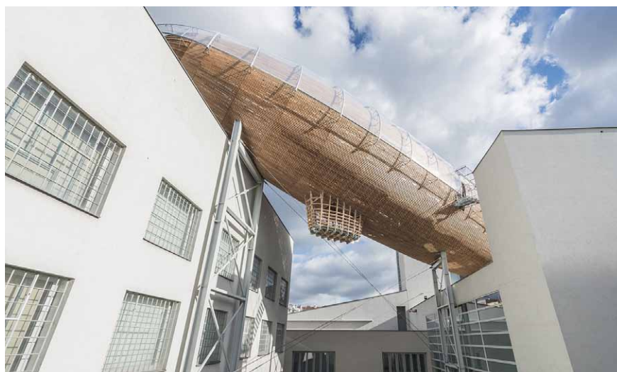
Podpůrná konstrukce se svislými bárkami, vykonzolovanou mostovkou a zajišťujícím ráhmem
