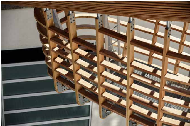
Součástí vzducholodi je zespodu na kostru zavěšená gondola přístupná z vnitřní paluby po ocelovém žebříku
