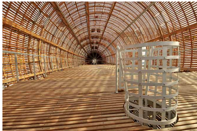
Součástí vzducholodi je zespodu na kostru zavěšená gondola přístupná z vnitřní paluby po ocelovém žebříku
