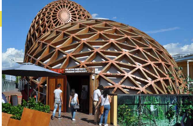
Konstrukce pavilonu Malajsie s prvky spojenými viditelnými sty nikovými plechy
