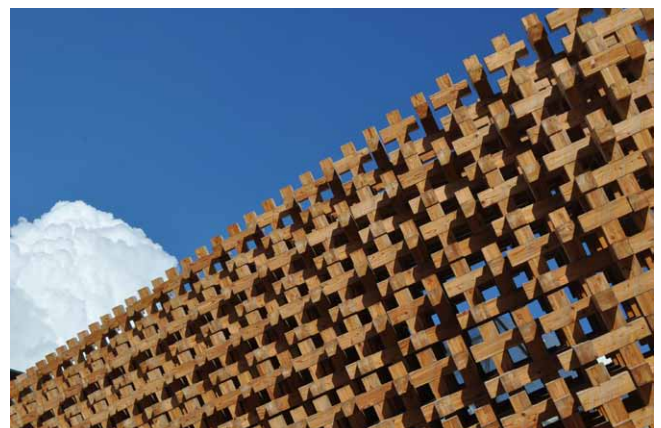
Detail vnitřní stěny japonského pavilonu vytvořené tradiční technikou ve tvaru roštu
