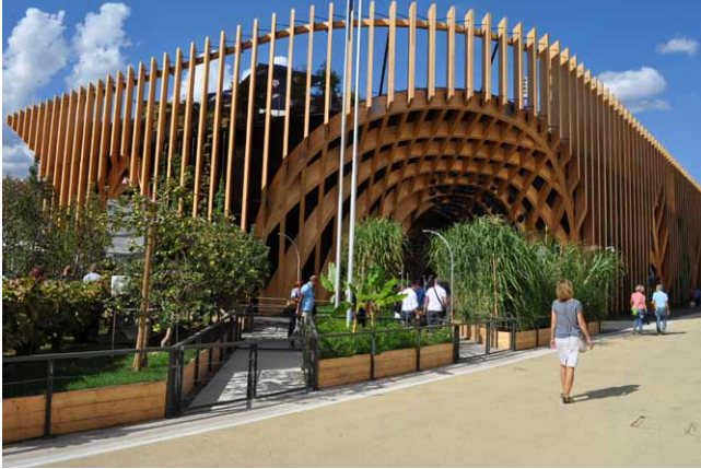
Exteriér a interiér pavilonu Francie s lepenou nosnou konstrukcí
