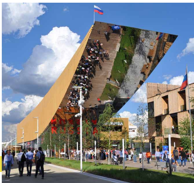
Monumentální pavilon Ruska s dřevěným opláštěním a vysokým krakorcem s velkoplošným zrcadlem
