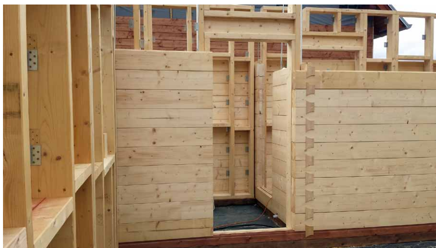
Obvodová konstrukce se nejprve sestaví v dílně a podle ní se na míru zhotoví rám izolační předstěny
