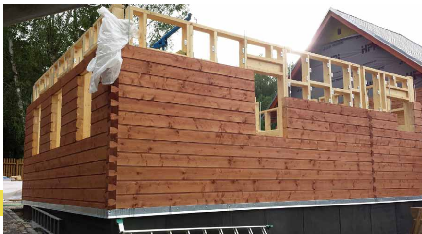
Základ každé stěny tvoří impregnovaný KVH hranol s plechovou okapnicí. Všechny hranoly ve stěně se kromě rohových spojů ještě fixují závitovými tyčemi
