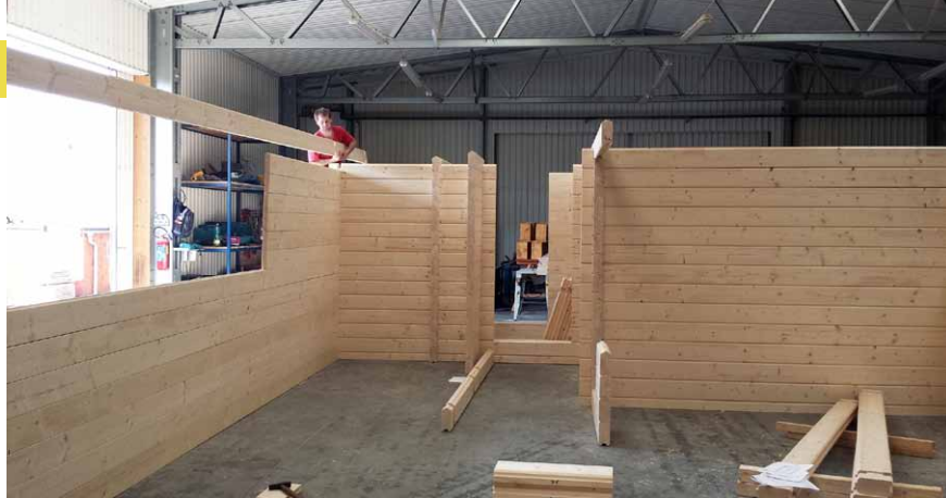
Obvodová konstrukce se nejprve sestaví v dílně a podle ní se na míru zhotoví rám izolační předstěny
