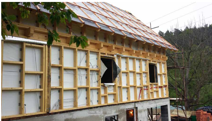
Umístění izolačně-montážní předstěny je možné jak uvnitř stavby, tak i zvenčí
