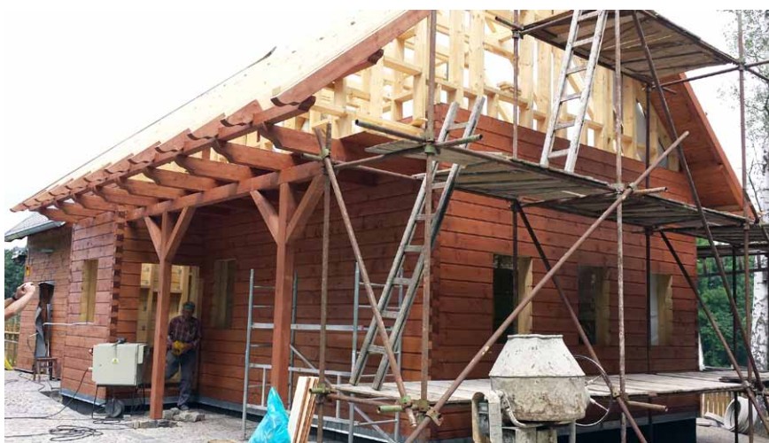
Konstrukce podkrovní je provedena rámovou technologií, pro střechu je použita nadkroevní izolace
