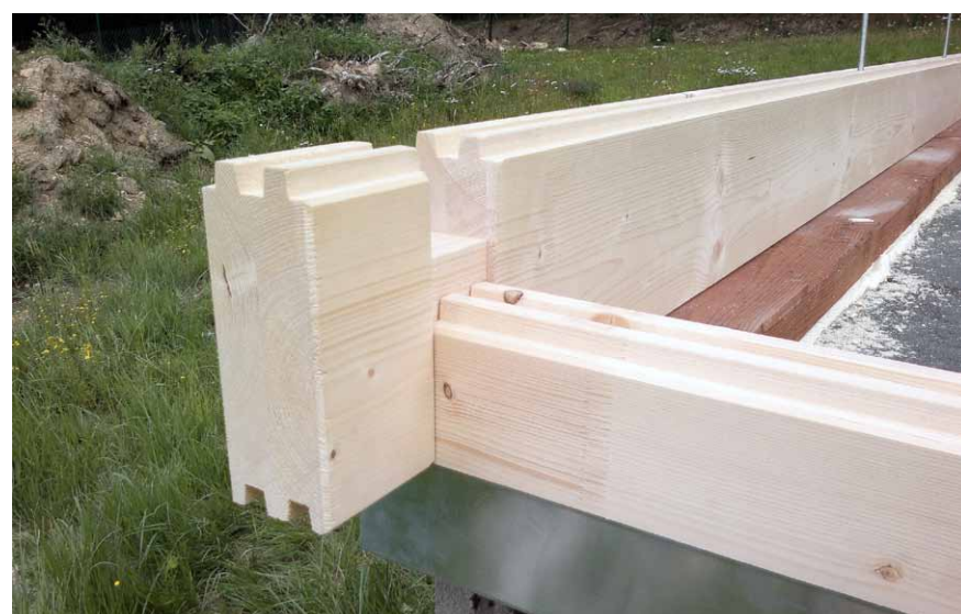
Základ každé stěny tvoří impregnovaný KVH hranol s plechovou okapnicí. Všechny hranoly ve stěně se kromě rohových spojů ještě fixují závitovými tyčemi
