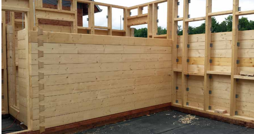
Umístění izolačně-montážní předstěny je možné jak uvnitř stavby, tak i zvenčí
