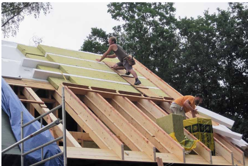
Konstrukce podkrovní je provedena rámovou technologií, pro střechu je použita nadkroevní izolace
