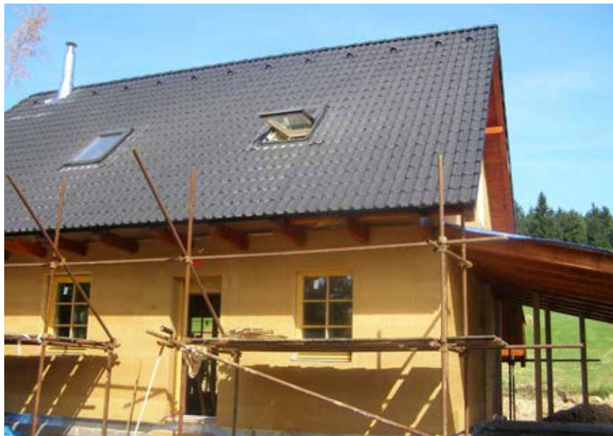
Venkovní opláštění konstrukce před aplikací fasády
