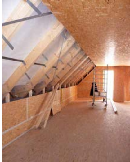
Instalace svěšeného stropu podkrovní
