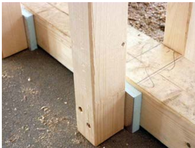
Detail kotvení základového prahu, hlavních konstrukčních prvků a přerušení tepelných mostů
