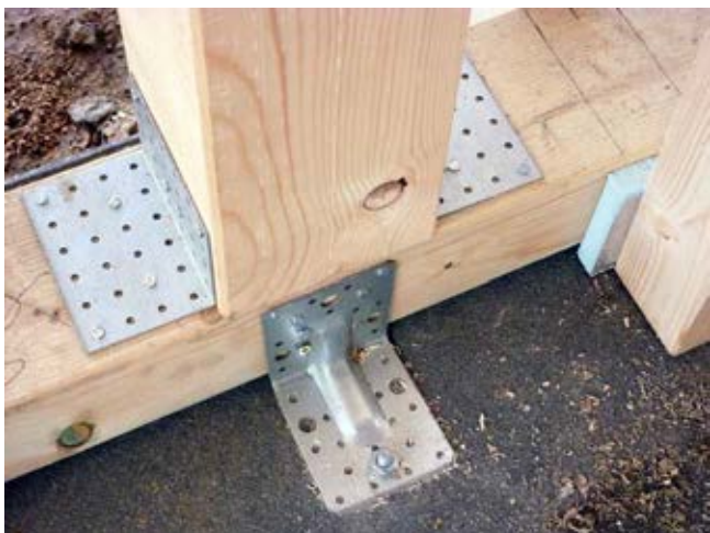
Detail kotvení základového prahu, hlavních konstrukčních prvků a přerušení tepelných mostů
