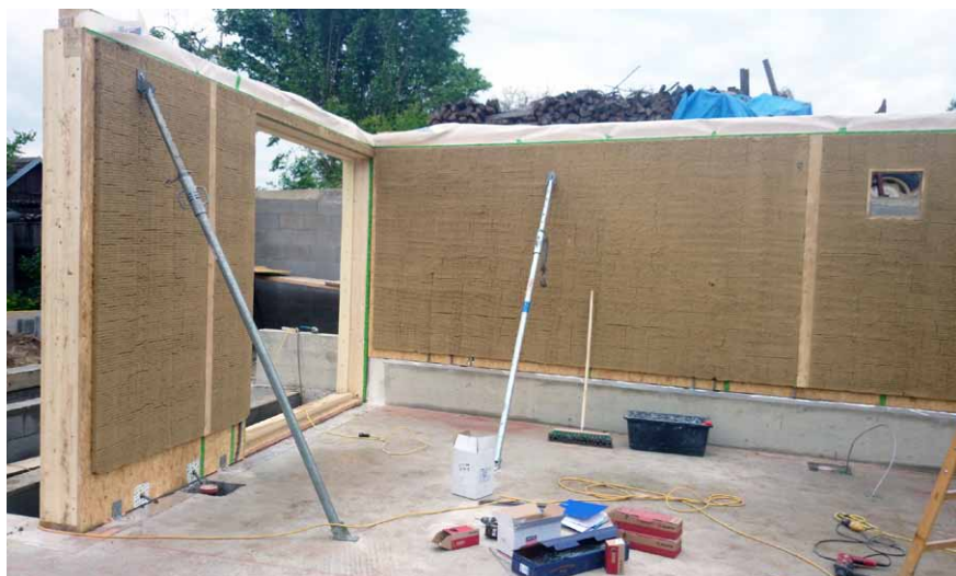
Montáž stenových panelov na betónovú dosku
