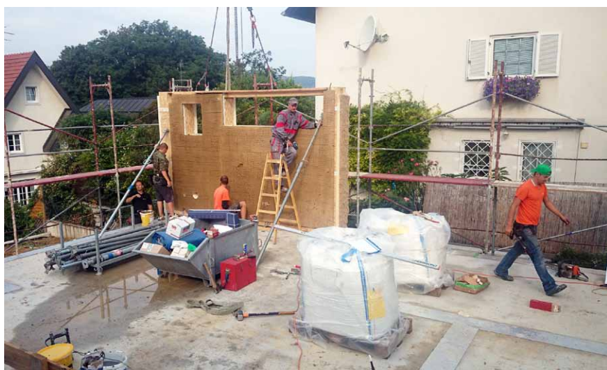
Montáž stenových panelov na betónovú dosku
