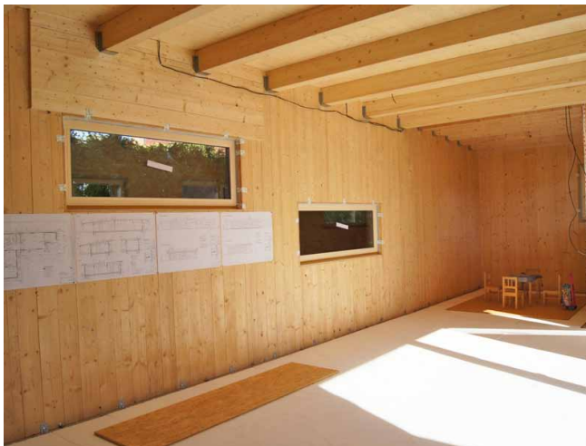
Upevnění stropnic pomocí vrutů a ocelových třmenů
