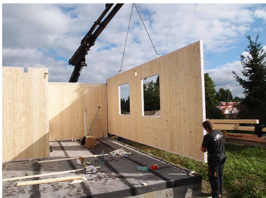
Ukládání panelů v 1. NP do maltového lože a k předem upevněným kotvicím úhelníkům
