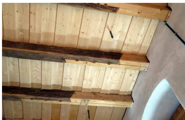
Vývoj krovových konstrukcí a možné opravy prvků lze sledovat jak na exponátech, tak i na samotném objektu muzea
